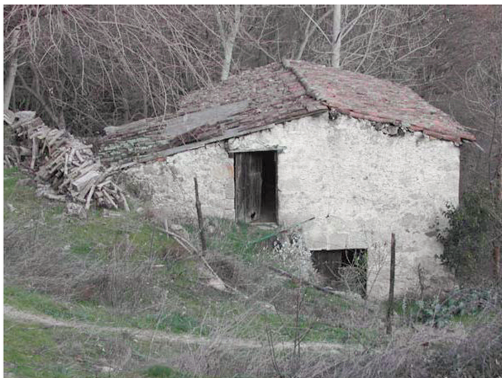
Molino de Abajo: Vista General y Compuerta
